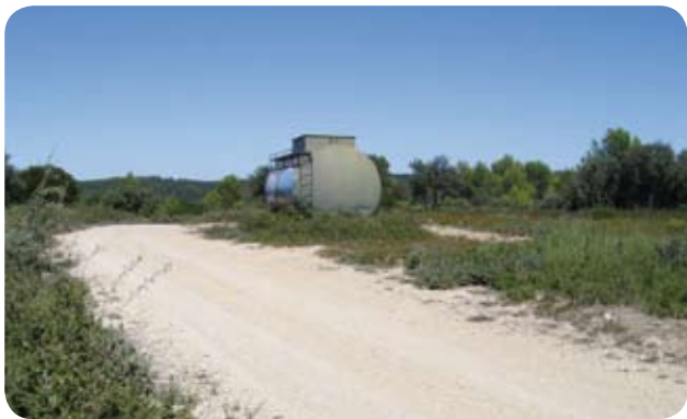
Point d'eau DFCI du Sommiérois ayant fait l'objet d'une normalisation en 2010 © P. MORIN
